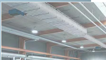
Questa sezione rettangolare è realizzata con speciali membrane interne per mantenere la struttura e con dei supporti sui quattro lati. Questo assicura che il diffusore contrasti la naturale tendenza al rigonfiamento e mantenga il profilo rettangolare quando l'impianto è acceso.
